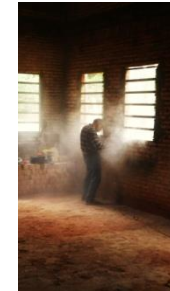
Preparing for conduits at Barrio Parque.
